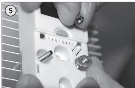
*Зафиксировать радиаторный распределитель на отопительном приборе при помощи резьбовой шпильки М3, двух гаек М3 и шайб. Усилие при закручивании гаек М3 должно составлять 1,2 Н·м.*
