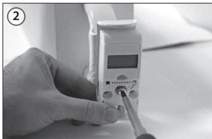
*Зафиксировать радиаторный распределитель INDIV-X-10 на кронштейне с помощью двух винтов М4. Усилие при закручивании винтов должно составлять 1,2 Н·м*
