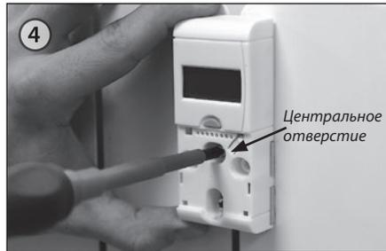
Продеть монтажную пластину между секциями радиатора таким образом, чтобы центральное отверстие теплового адаптера находилось в точке монтажа (см стр. 2, 3).
