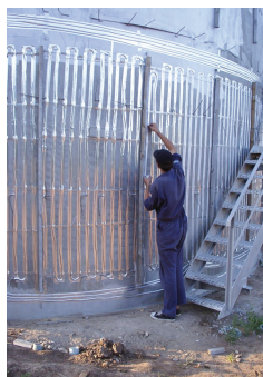
Монтаж кабеля для обогрева уличного бака с водой
