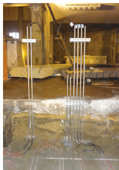
Монтаж нагревательного кабеля на бетонном основании
