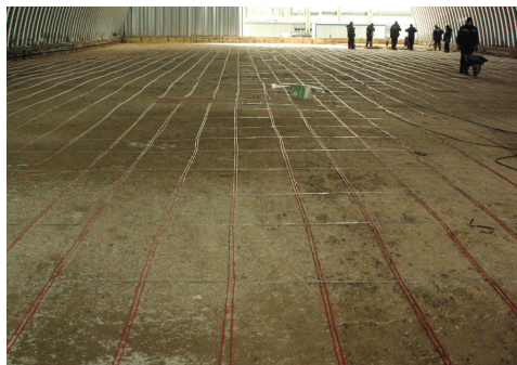
Монтаж нагревательного кабеля в песчаной засыпке
