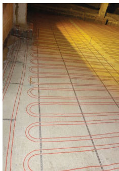
Монтаж нагревательного кабеля на бетонном основании
